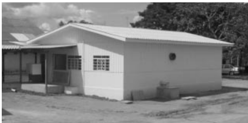
Das Krankenhaus San Antônio in Sinop, Mato Grosso
