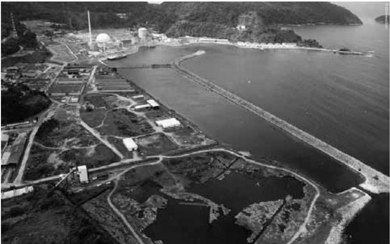
Die drei Kernkraftwerke in Angra dos Reis am Atlantik (vorne die Baustelle für Nr. 3) liefern zwei Prozent des gesamten brasilianischen Stromangebots
